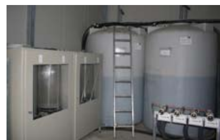
In alto da sinistra, locale additivi e compressori e gruppi di dosaggio additivi.
